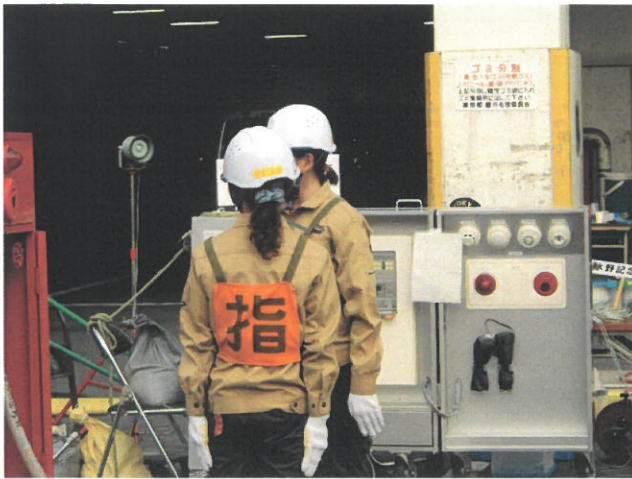
復旧操作完了
