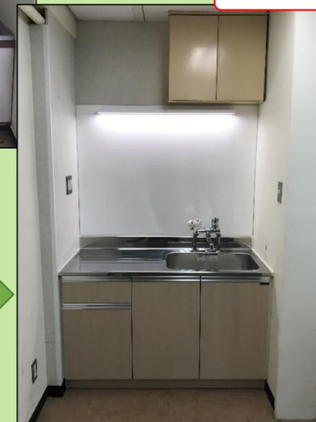
RN工事で**ガス設備廃止**となる為、ガス湯沸器を電気湯沸器に更新し、併せて流し台・照明LED化を実施致しました。蛇口は、**熱湯(92℃)**、混合栓では**原水及び給湯(60℃)**の出水が可能となっております。
