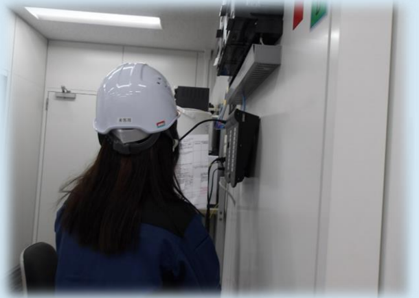
火災発生の放送実施
