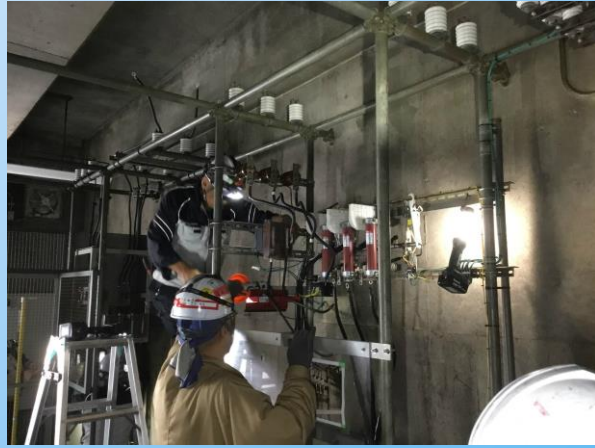
電気室改造状況
