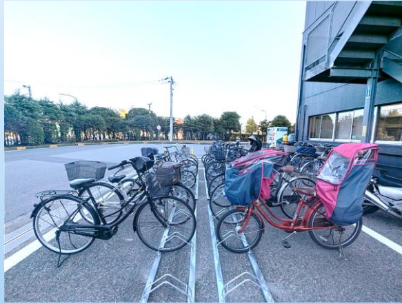
駐輪スタンド改修状況
