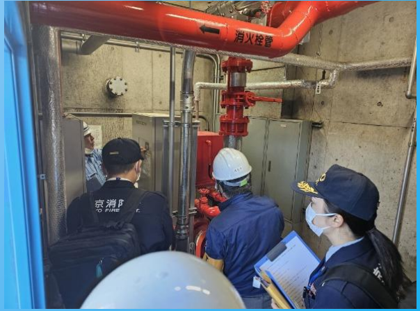
消火栓ポンプ消防検査状況
