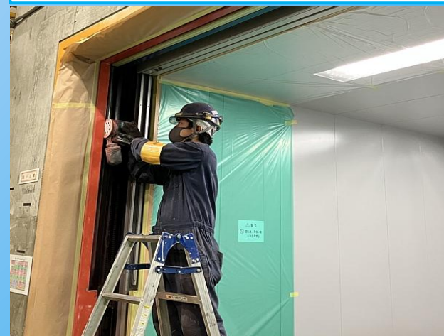
ELV更新工事状況② （三方枠塗装前ケレン作業）
