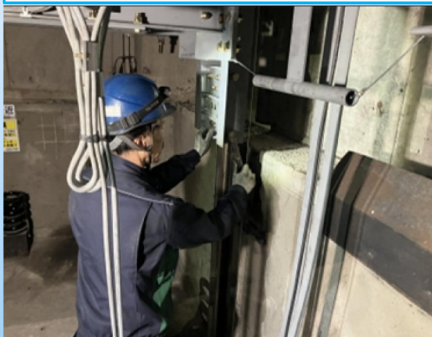
ELV更新工事状況① （ピット内かご用ガイドレール調整）
