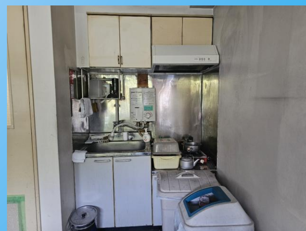
附属事務棟電気給湯器新設工事更新対象箇所
