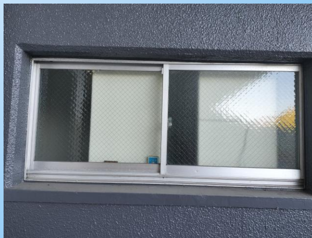
主要建具更新工事（アルミ建具）更新対象箇所
